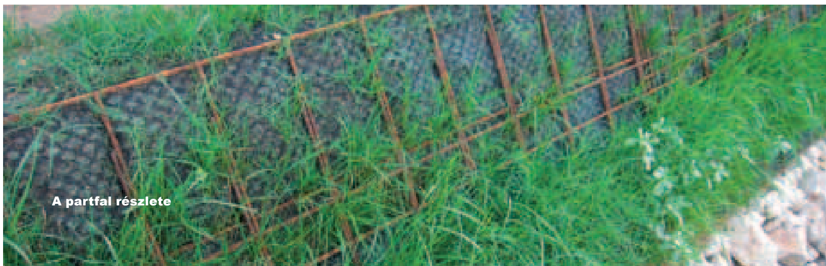
Az elkészült talajtámfal. A lábazatnál látható kövek betonágyban vannak elhelyezve, szerepük a lejtő aljának védelme kimosódás ellen.
