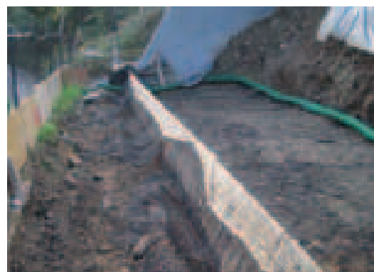
A műtárgy mögötti drénezés részlete, a talajtámfal építésének kezdeti szakaszában. A vízgyűjtő dréncső a föld alá kerülő helyiség alapjánál helyezkedik el.
