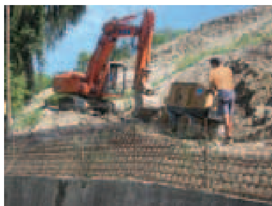
A feltöltött talaj tömörítésére a frontoldalon rendszerint egy kisebbfajta gépet használunk, amely nem tesz kárt a fémrácsban.
