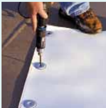
2 mechanikusan rögzíteni a membránt
