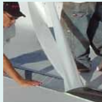
2 védőfóliát eltávolítani és a tekercset, az aljzat-hoz tapasztani, illetve egymásra lapolni
