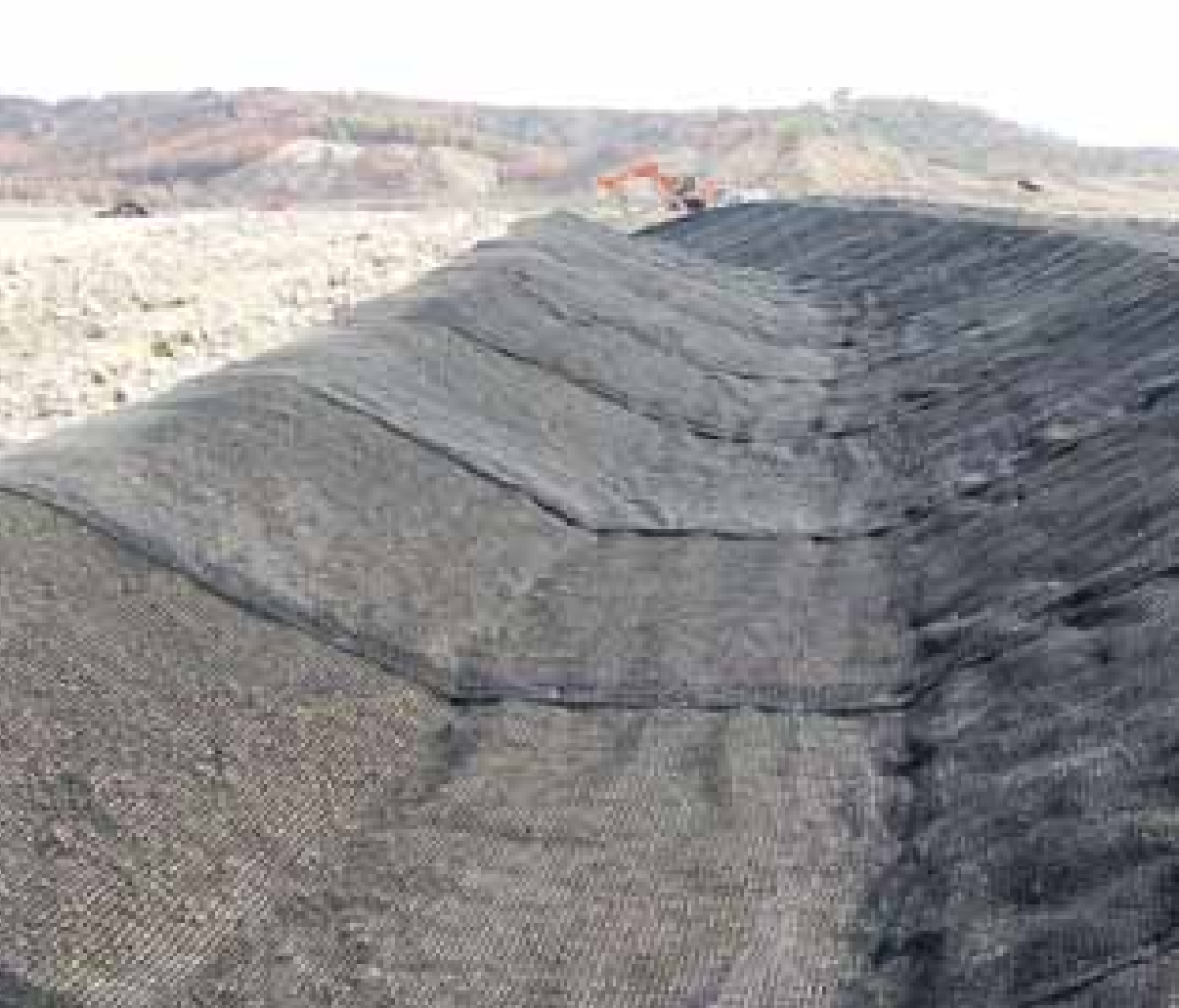
Vízvezető árok bélelése KMat RF 55 megerősített geomatraccal.
