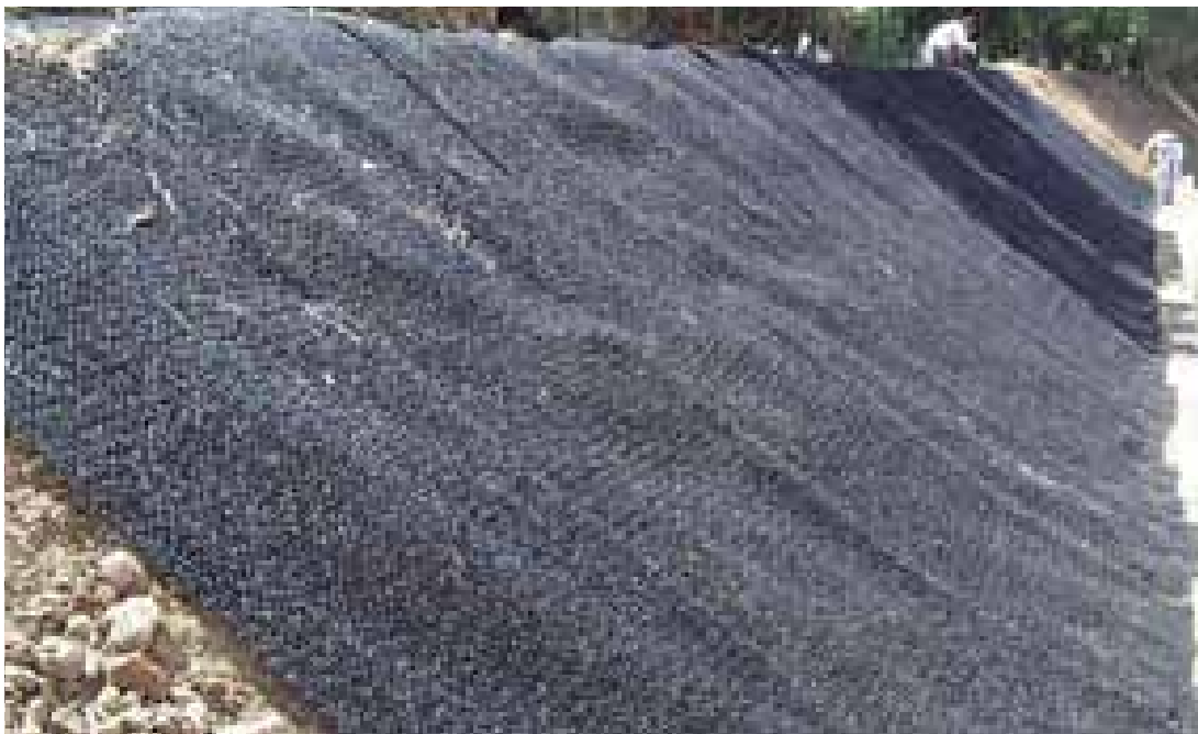
Száraz talajú rézsű erózió elleni védelme KMat felhasználásával.
