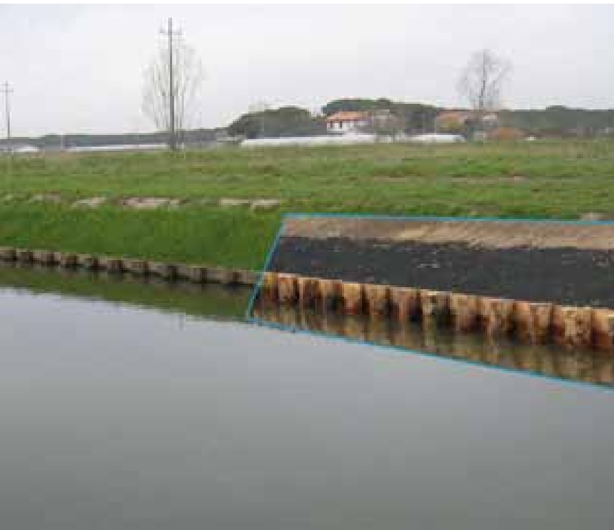
Rézsű stabilizálása egy vízvezető csatorna partján, KMat L felhasználásával.
